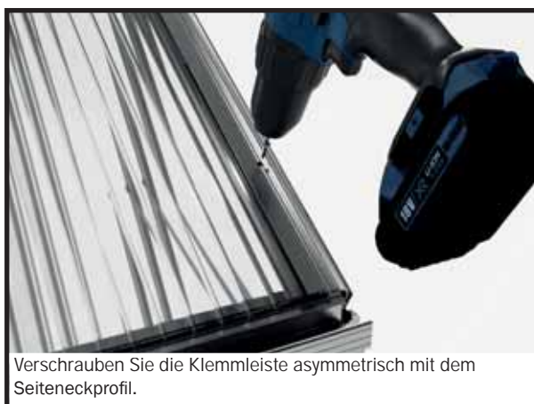
Für das Dacheckprofil nehmen Sie bitte eine Klemmleiste asymmetrisch und Blechtreiber 3,9x13 mm zur Hand.
