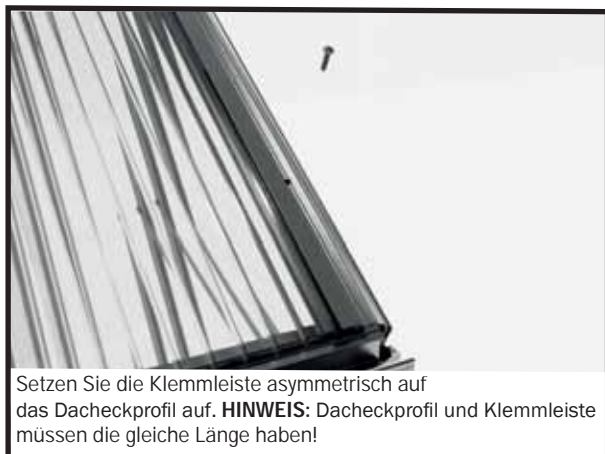
Verschrauben Sie die Klemmleiste asymmetrisch mit dem Seiteneckprofil.
