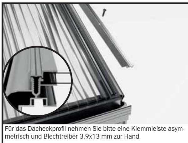
Setzen Sie die Klemmleiste asymmetrisch auf das Seiteneckprofil auf. HINWEIS: Seiteneckprofil und Klemmleiste müssen die gleiche Länge haben!
